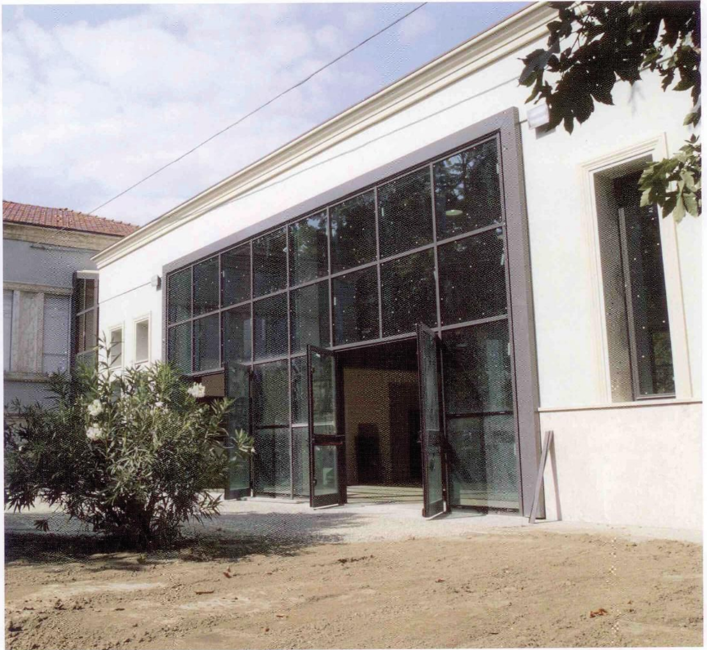
La palestra dall'esterno. Lavori di ultimazione.
