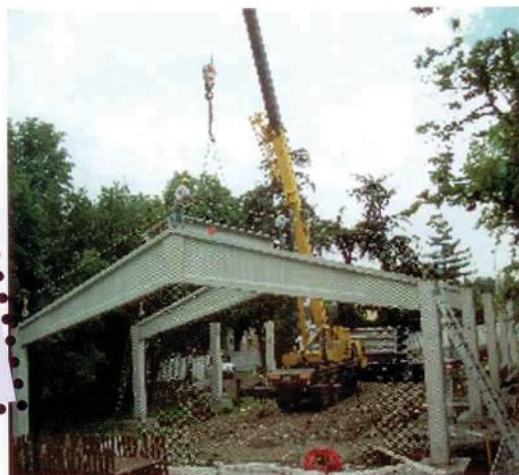
Il nuovo nido in costruzione
